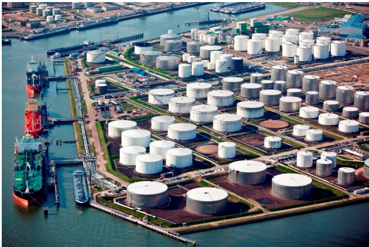
تصویر ۶۹۸: مخازنی که بر اساس استانداردهای API 620 & 650 ساخته شده اند.
