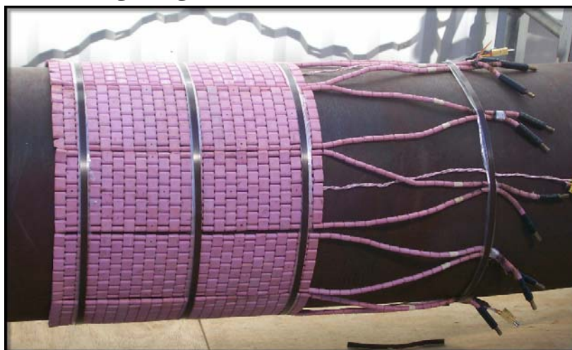
تصویر ۲۹۳: نمونه ای دیگر از عملیات حرارتی موضعی
