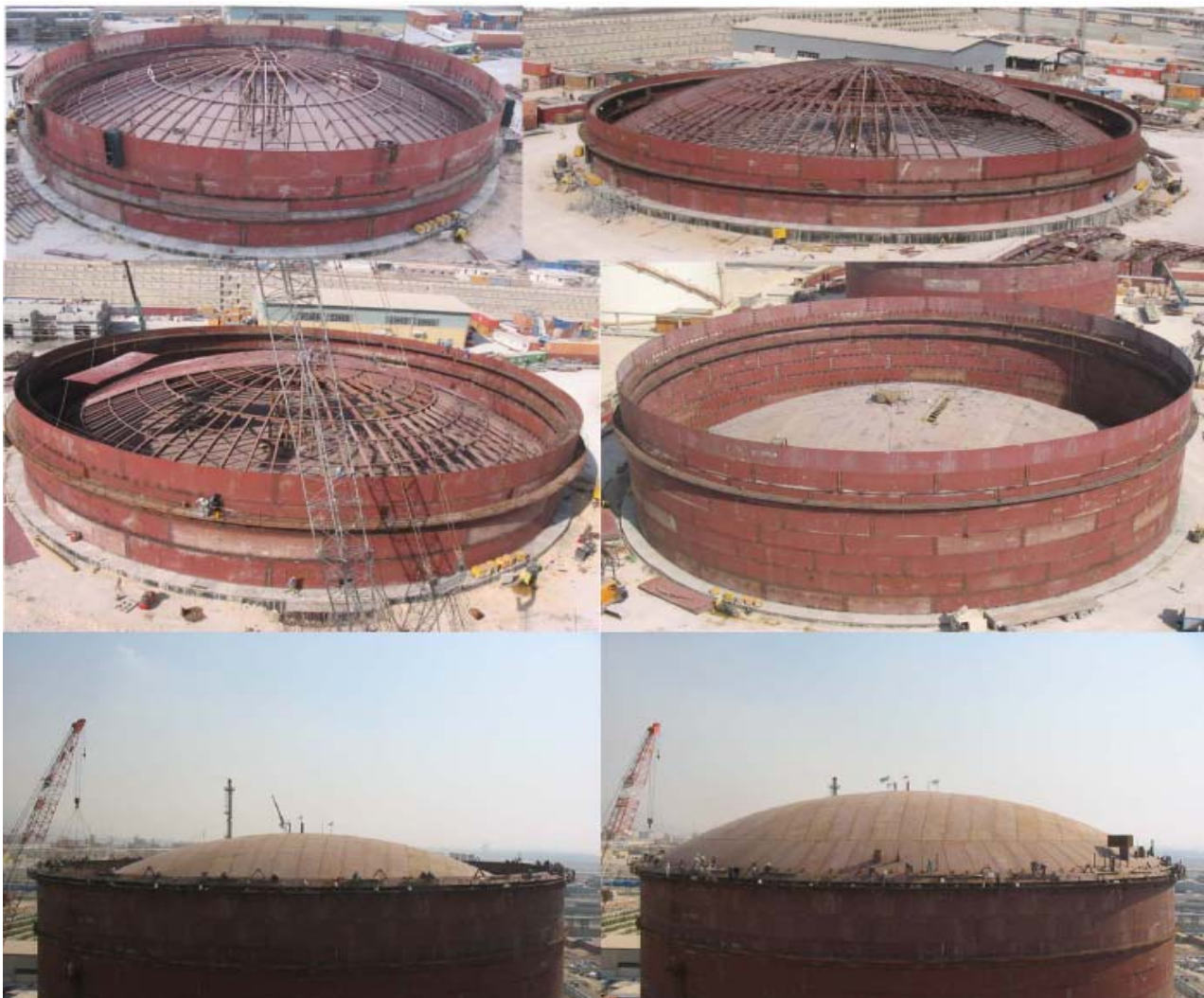
تصویر ۶۸۹: عکسی از مراحل ساخت مخزن ذخیره ای
