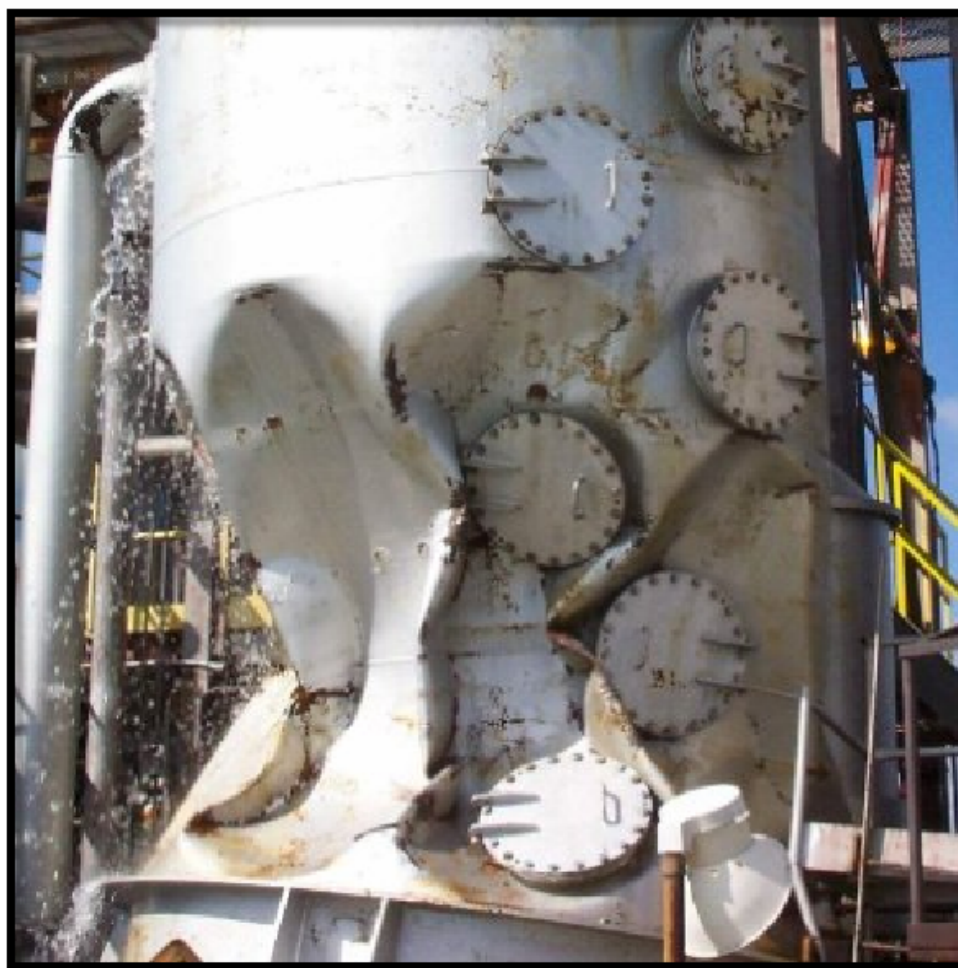
تصویر ۷۴۰: تخریب مخزن تحت فشار هنگام تخلیه بدلیل عدم رعایت باز بودن ونتهای سقف
