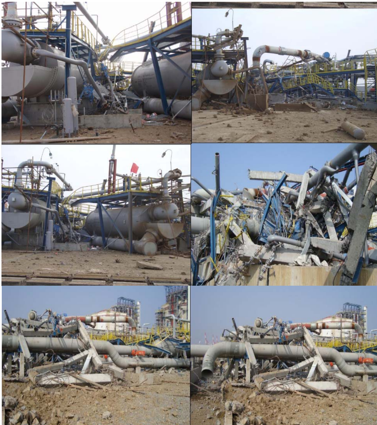
تصویر ۷۲۴: خرابی های ناشی از انفجار تست هوا در لوله های روزمینی
