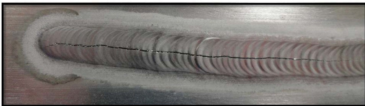
تصویر ۵۷۳: ترک طولی در جوش (Longitudinal Crack)
